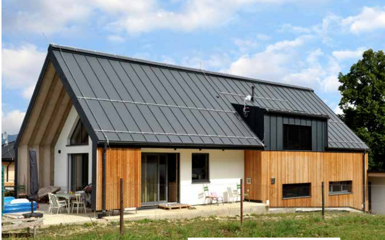
Rodinný dom v Liptovskej Štiavnici Autor | CREATERRA: Ing. arch. Zuzana Kierulfová
