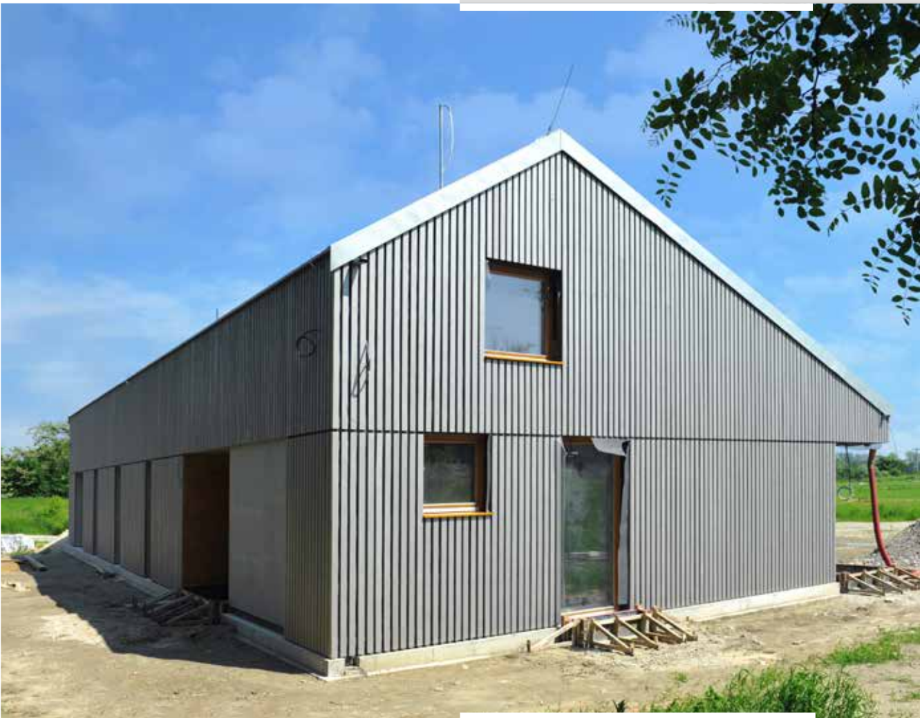
Farmársky dom v Hrubom Šúre Montovaný dom z CLT panelov Autor | Ing. arch. Jakub Kolarovič
