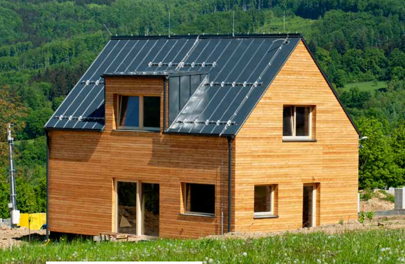
Rodinný dom v Hornej Súči Montovaný dom z CLT panelov Autor | Ing. arch. Fero Lehocký
