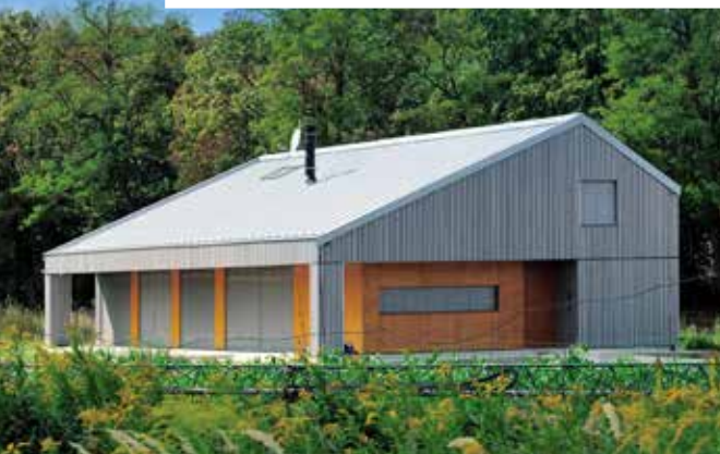
Farmársky dom v Hrubom Šúre Montovaný dom z CLT panelov Autor | Ing. arch. Jakub Kolarovič
