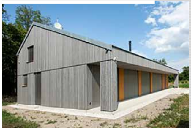
Farmársky dom v Hrubom Šúre Montovaný dom z CLT panelov Autor | Ing. arch. Jakub Kolarovič
