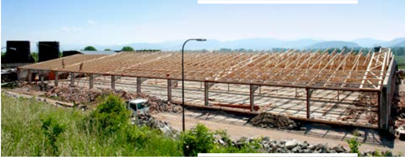
Poľnohospodárska hala v Nemšovej
