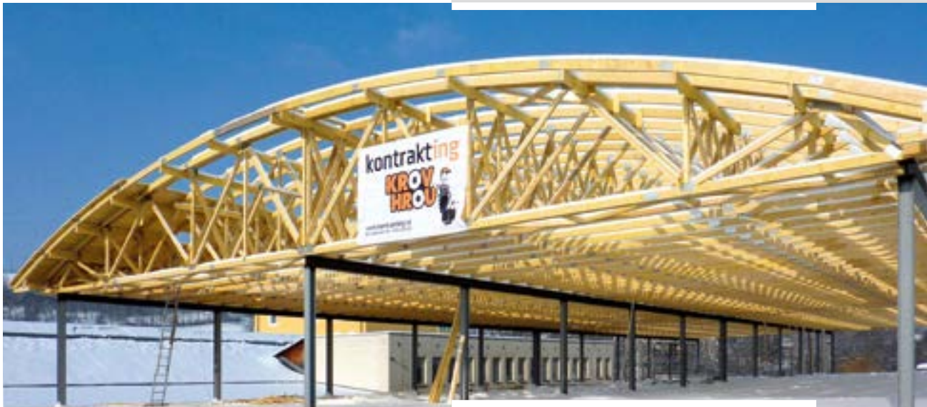
Vřrobnř hala vo Veľkom Rovnom Autor | Ing. arch. Lubomřr Zaymus
