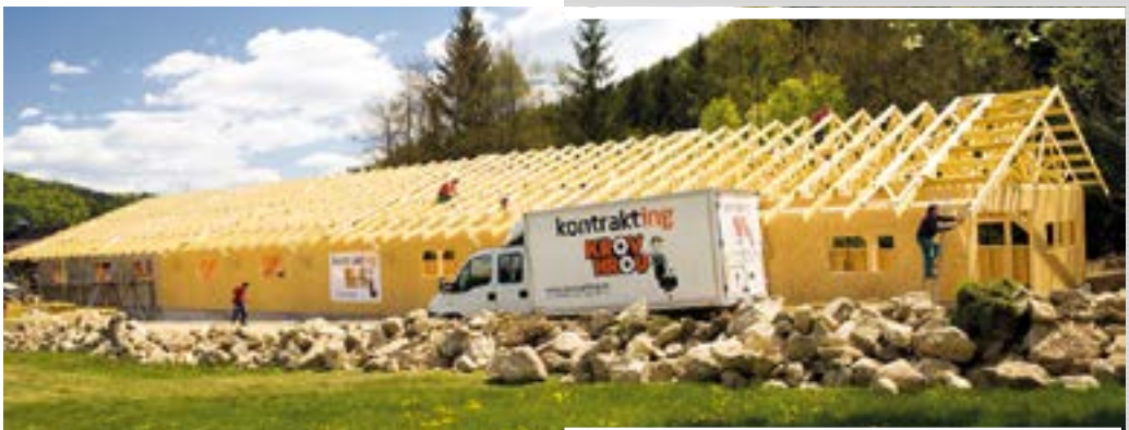
Prístrešok golfovej techniky, Tále Autor | Ing. Jaroslav Moravčík
